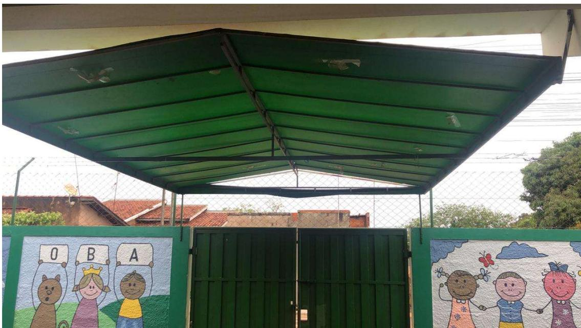
3.4.2 - 01 Unidade Substituição de Lona na medida 5,00m de comp. x 2,70m de largura:
