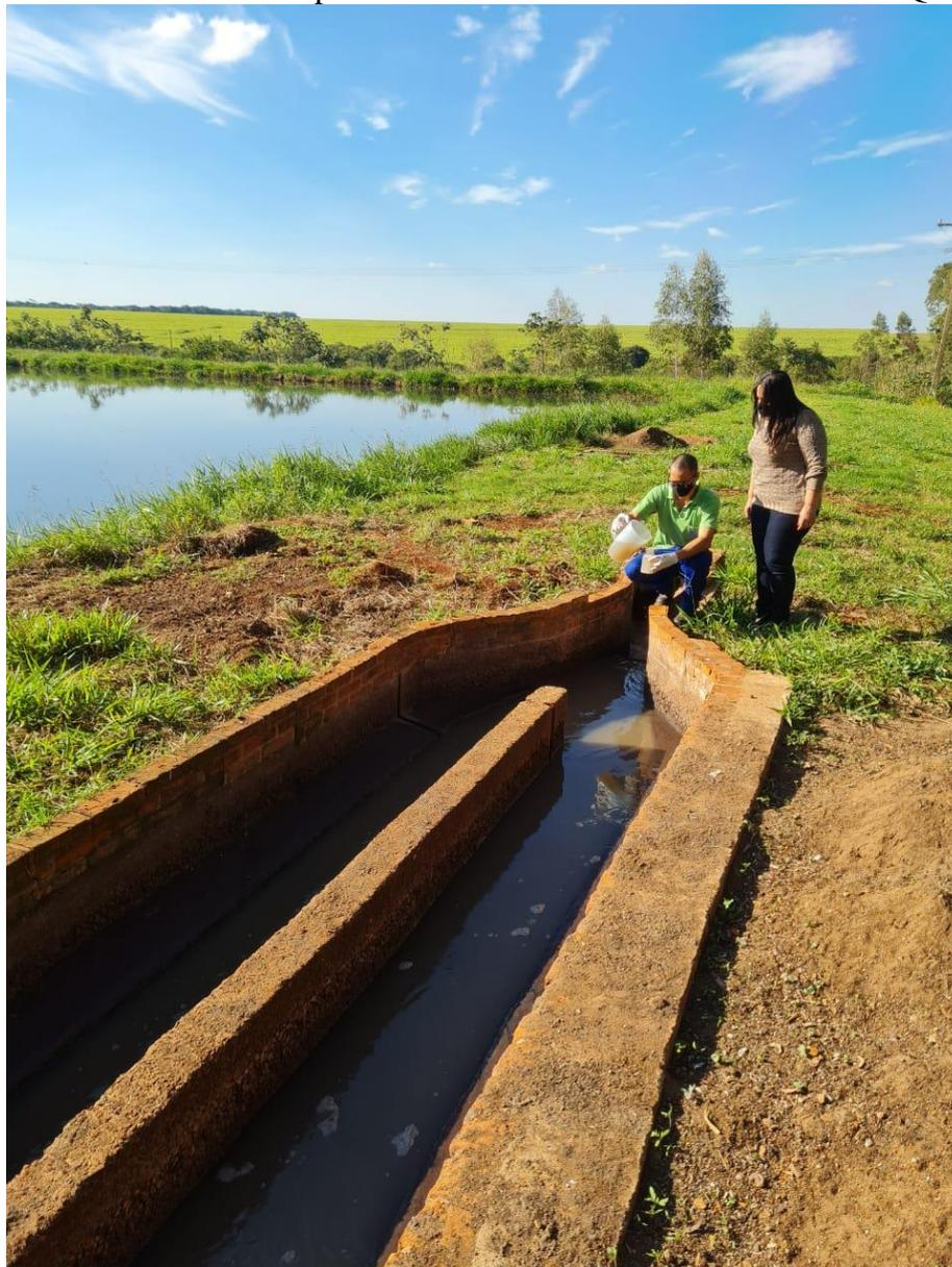
Figura 17: Calha Parshall para medição de vazão na ETE de Cândido Mota.
